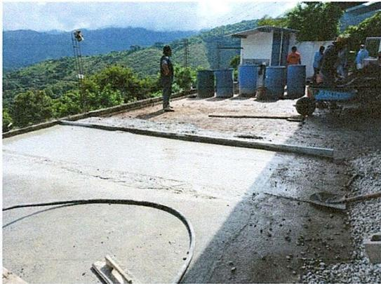
**Foto 3: REPARACIÓN DE LOSA DE PATIO**
